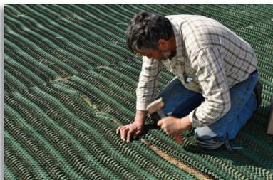
**TerraWeb®-strong** nicht auf weichem oder nassem Boden verlegen. Der Boden muss fest und gut drainiert sein.
